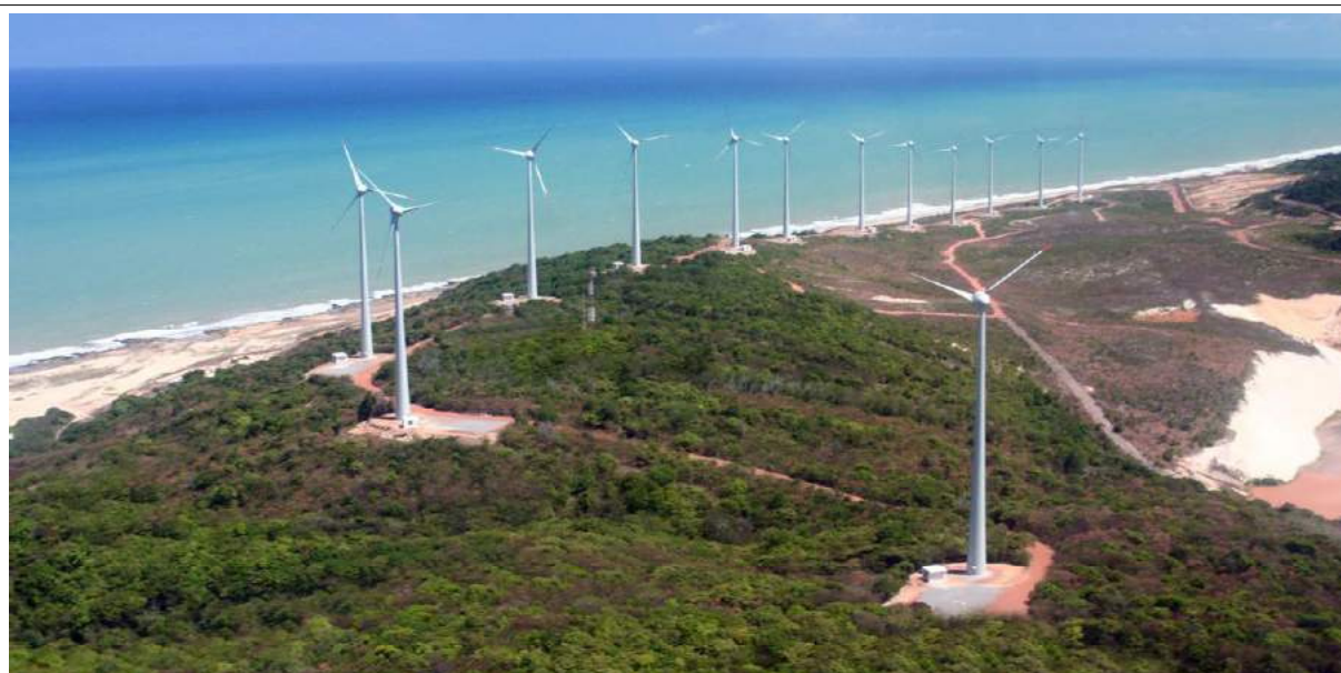
Figura 2.10 - Usina Eólio-Elétrica Millenium 10,2 MW (Paraíba), em operação desde abril/2008, com aerogeradores de 800 kW.
