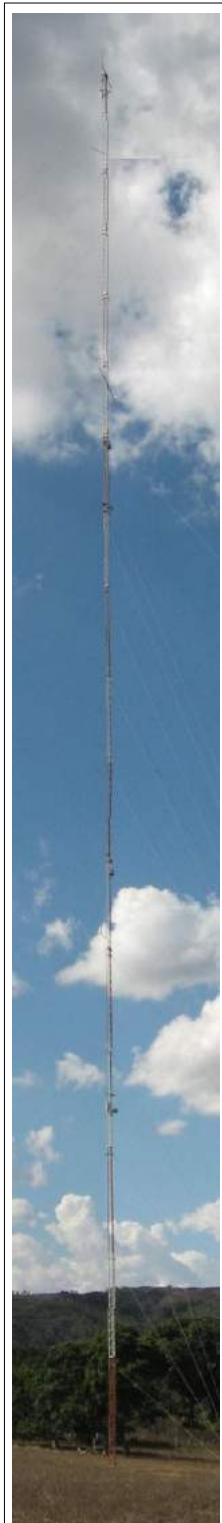
Figura 3.3 - Torre de monitoramento anemométrico de 100m de altura.
