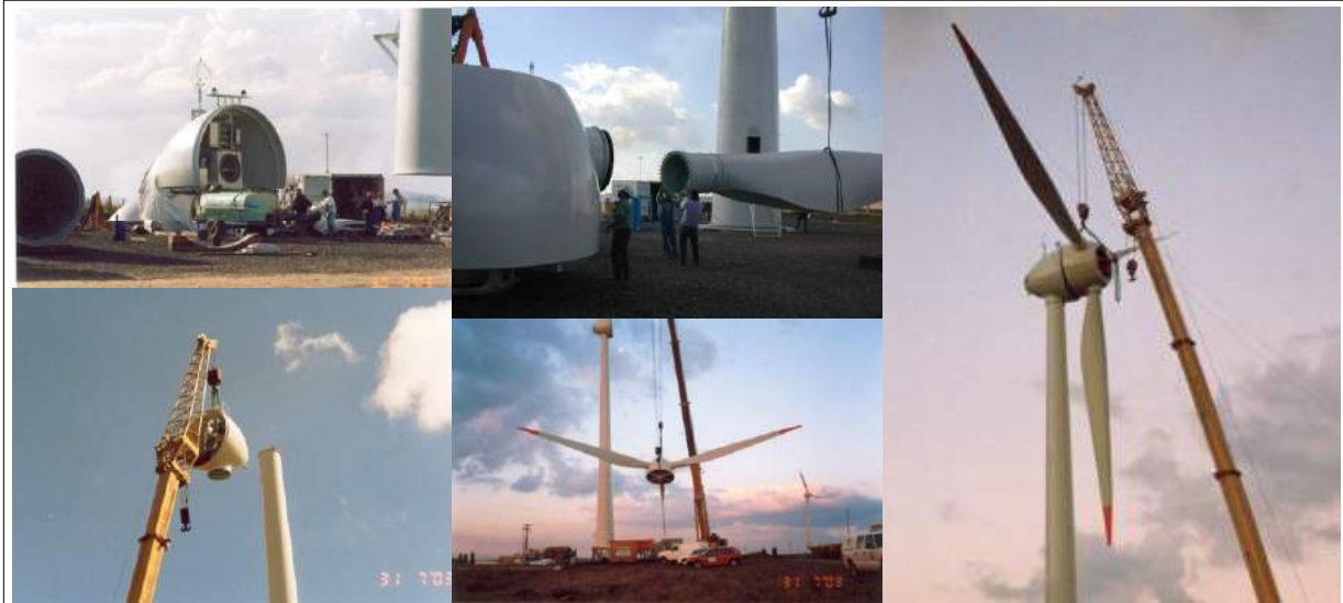
Figura 2.8 - Etapas na montagem de um aerogerador, com detalhes do posicionamento da nacele e do rotor.
