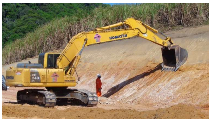
Figura 7 – Talude de corte da primeira banqueta
