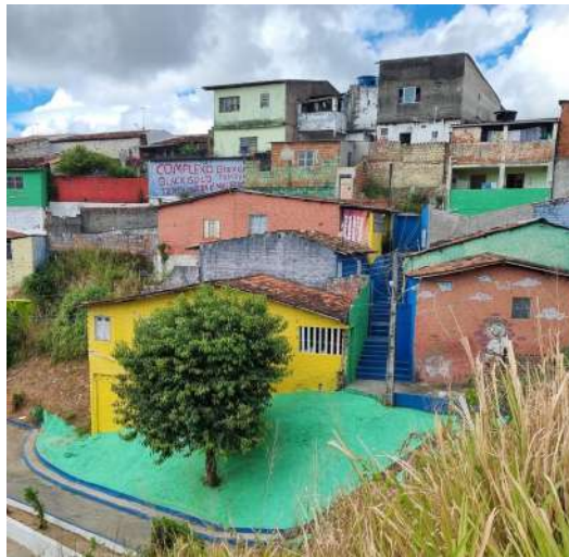
Construção de escadarias e pinturas em grota de Maceió. Foto: Setrand Alagoas
