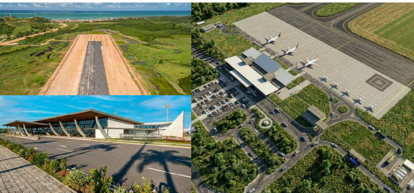
Perspectiva do projeto do Aeroporto Costa dos Corais-Maragogi e pista em construção. Fontes: DER-AL e Thiago Sampaio-Agência Alagoas)
