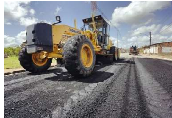
Obras do Pró-Estrada em Alagoas. Foto: Setrand Alagoas
