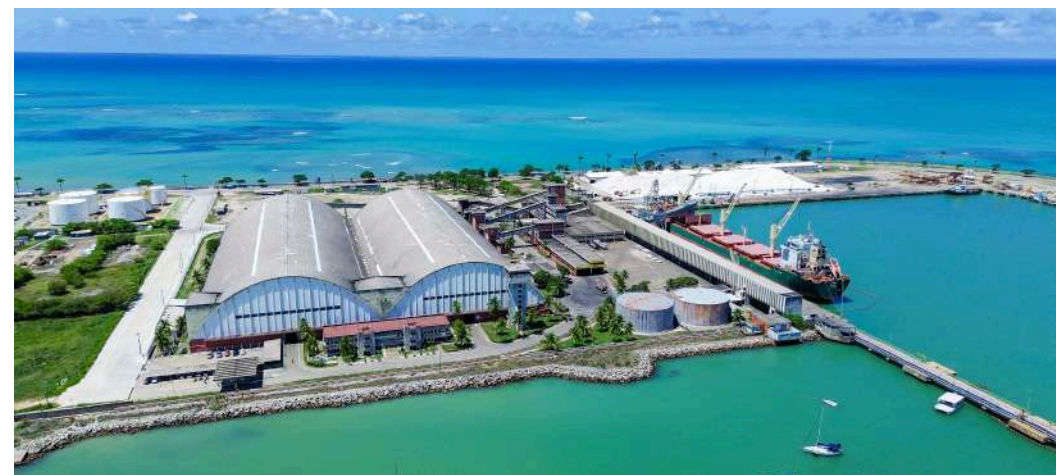
Armazéns do porto - Maceió
