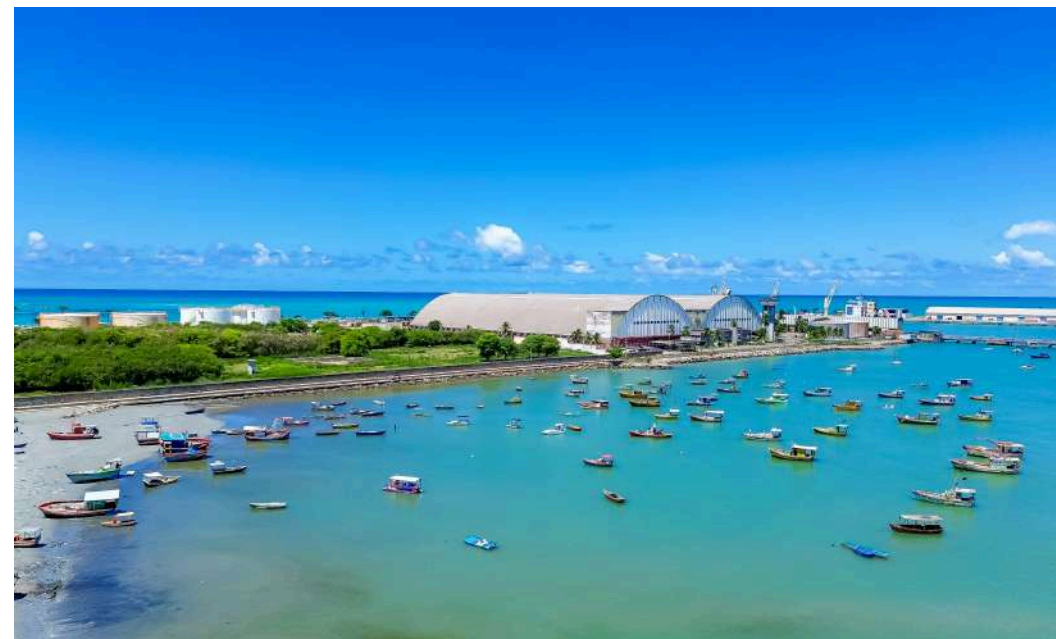
Armazéns do porto - Maceió
