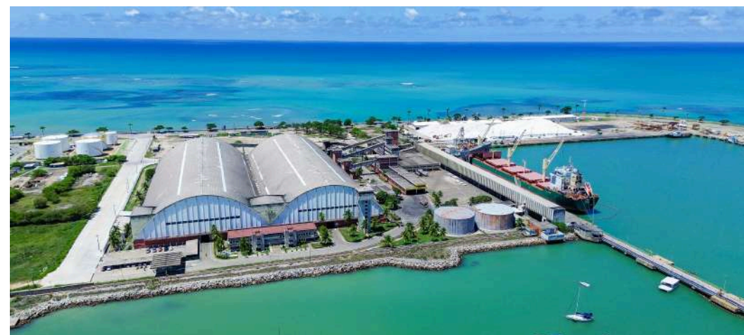
Armazéns do porto - Maceió
