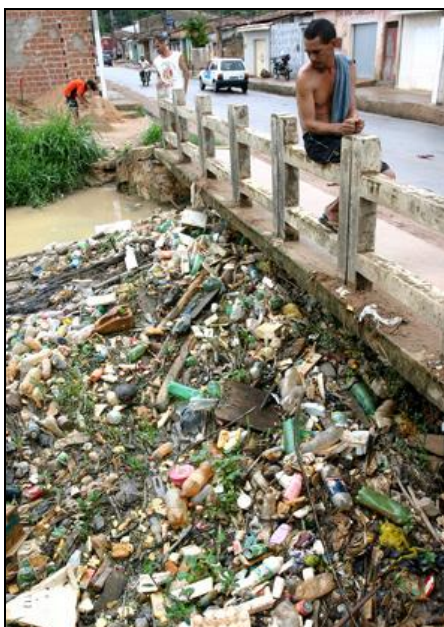
Figura 6. Ponte sobre riacho do Silva no bairro Bebedouro com quantidade expressiva de lixo
