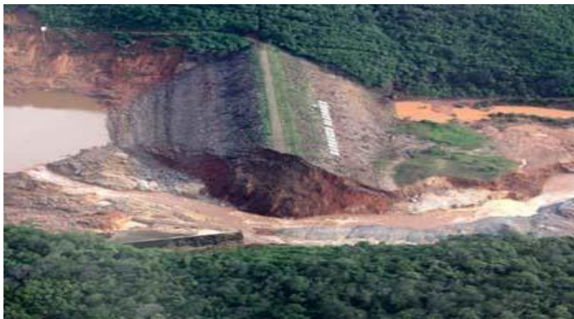
Figura. 02 - Rompimento da Barragem de Algodões Fonte: Equipe técnica Oasis Construções
