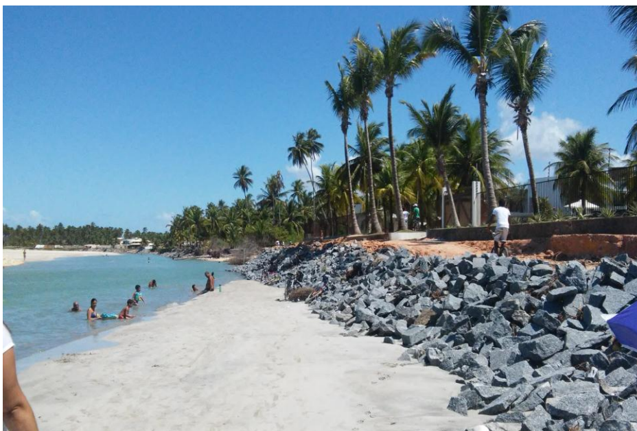
Figura 4. Trecho com processo de erosão, medida de contenção. Fonte: SANTOS 2015.
